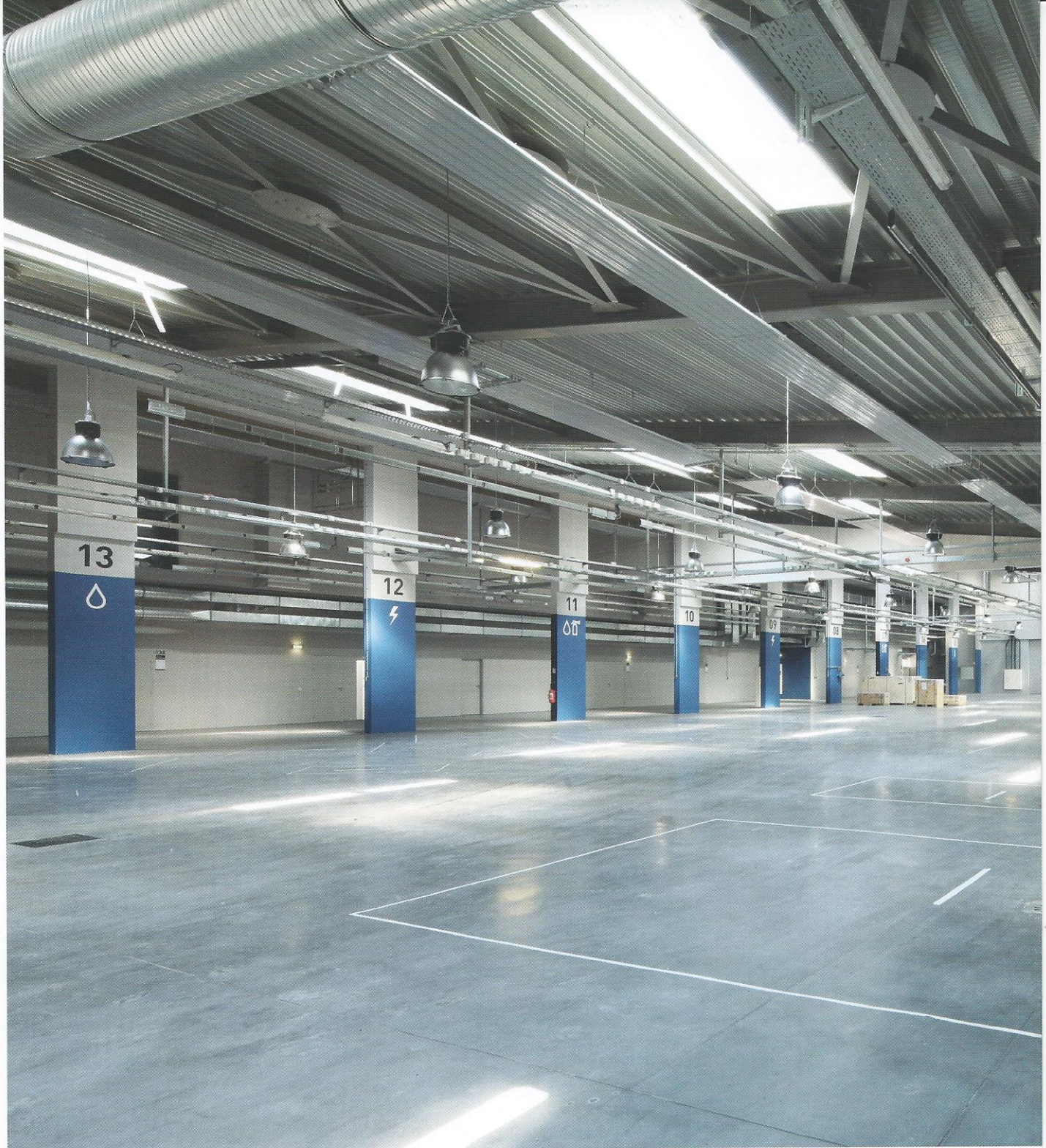
Perspective générale de la grande halle des ateliers Perspective view of the machining workshop hall Gaston Bergeret - AS.ARCHITECTURE-STUDIO - Signalétique intérieure : Artkas
