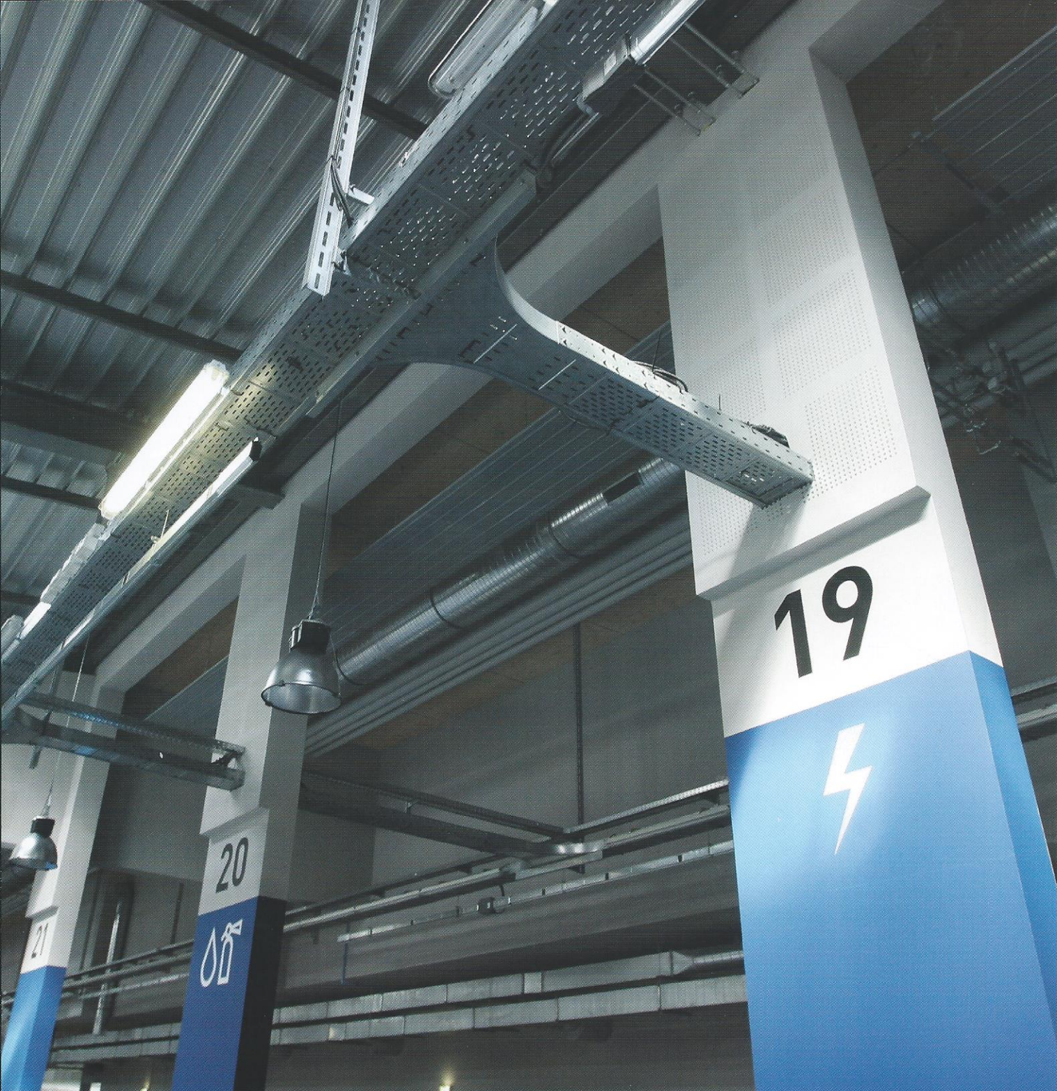
Intérieur de la grande halle des ateliers - signalétique Interior of the machining workshop hall - signage
